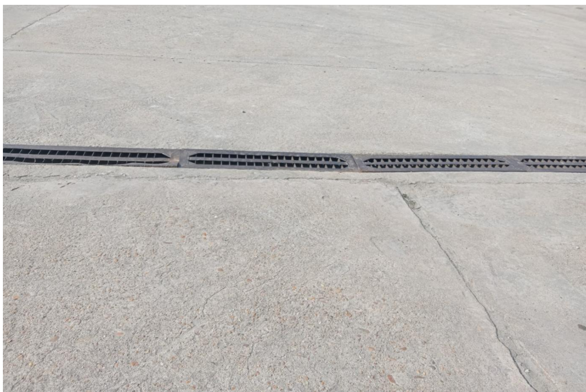
Hình 1.4. Sân bãi có độ dốc, mương gom nước mặt
